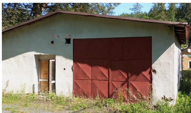
Obr. 33 Hasičská zbrojnice - Malovice
